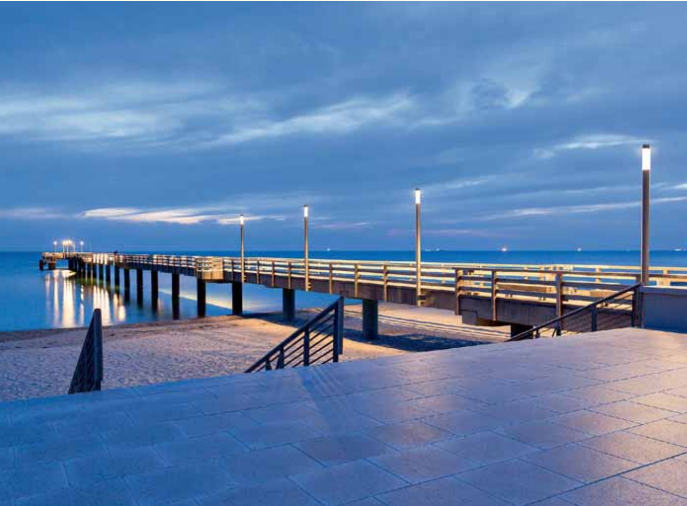
Die neue Beleuchtung auf der Brücke vereint vier unterschiedliche Lichtkom- ponenten
