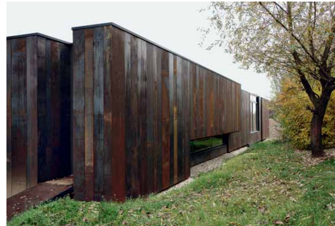
Haus 35/5 (35 m lang, 5 m breit) in Fürstzell-Irsham wurde mit dem 1. Preis der IHM 2014 ausgezeichnet Alle Fotos: Architekten
