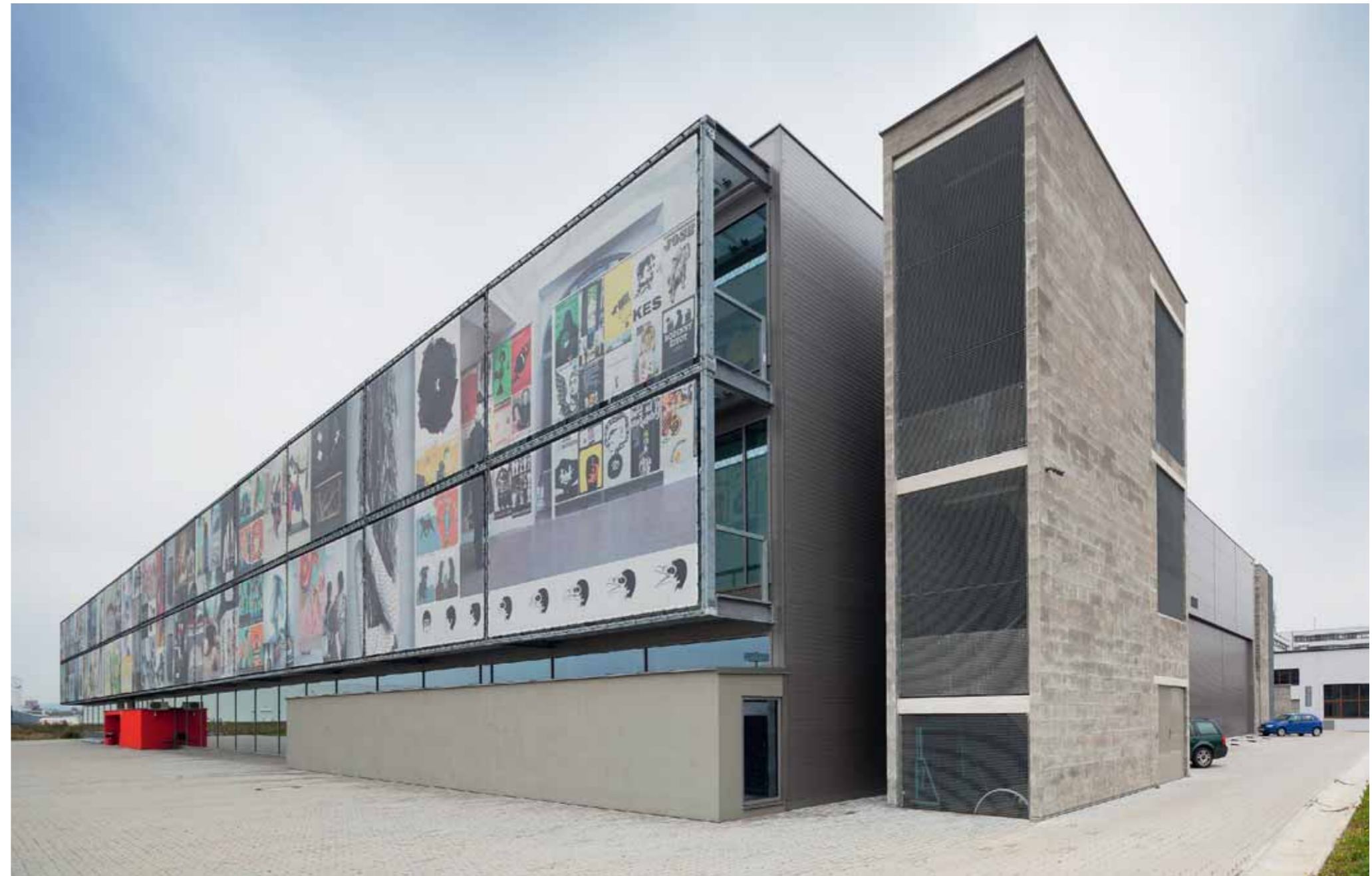
Die mit textilen Bildtafeln bespannte Westfassade macht deutlich, dass es sich hier mitnichten um eine Lagerhalle handelt
