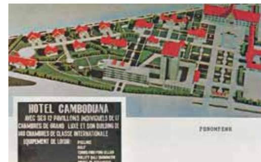
Das Hotel Cambodiana ist noch heute ein Zeugnis des aufstrebenden Kambodscha der sechziger Jahre. Darunter der Entwurf des Bauministeriums Foto 2008: Moritz Henning Abb.: Norodom Sihanouk, „Photo-Souvenirs de mon Cambodge“
