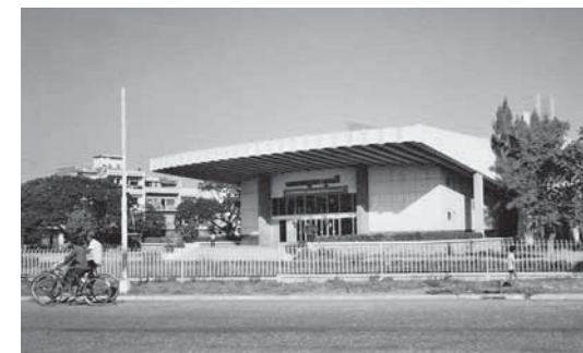
Das Chenla Cinéma d'Etat wurde bei der Renovierung mit allerlei wichtigster Dekoration überformt, doch die Konstruktion des auf zwei monumentalen Pfeilern und einem gigantischen Träger sich aufspannenden Daches ist noch immer erkennbar Foto 2008: Moritz Henning
