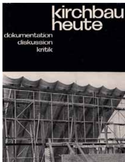
Titel des 1969 im Leipziger St. Benno-Verlag erschienen Buches „Kirchbau heute“, mit einem Baustellenfoto der St. Gabriel-Kirche in Wiederitzsch
