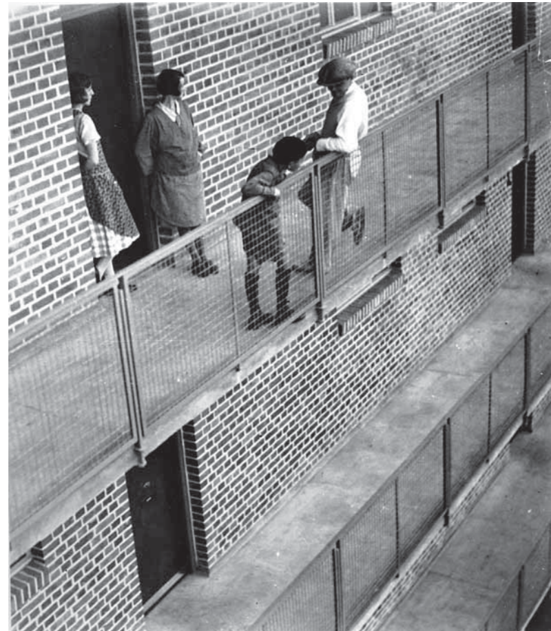
Links: Laubenganghäuser in Dessau-Törten, von der Bauabteilung des Bauhauses unter Hannes Meyer 1929/30 errichtet: Die 47 Quadratmeter kleinen Mietwohnungen waren spottbillig und kamen damit dem Ideal der „Volkswohnung“ sehr nahe.
