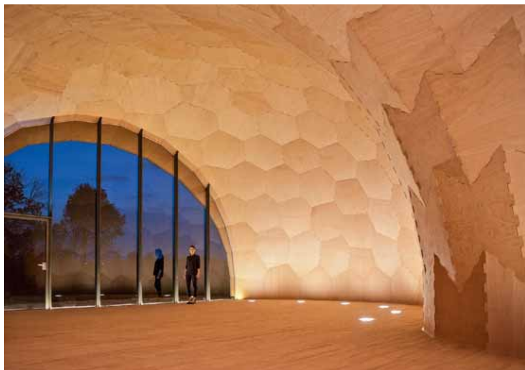
Die tragende Plattenkonstruktion des Forstpavillons auf der Landesgartenschau in Schwäbisch Gmünd 2014 wurde – in Zusammenarbeit von ICD und ITKE sowie dem Institut für Ingenieurgeodäsie (IIGS) – robotisch als Holzleichtbauschale gefertigt Fotos: ICD/ITKE Universität Stuttgart
