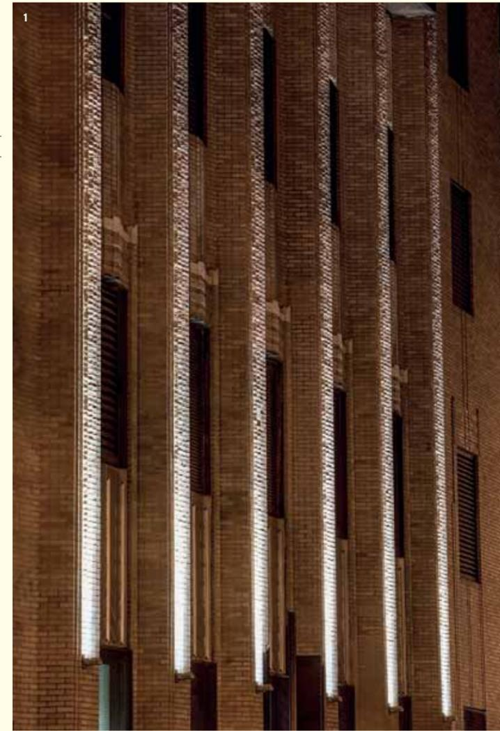
Der Grasshopper **3** akzentuiert die schlanken Lisenen **1**, der Lightscan **4** den oberen Gebäudeabschluss **2**. Die an der Fassade sitzenden Strahler sind durch LED-Optoelektronik und witterungsbeständige Aluminiumgehäuse nahezu wartungsfrei.
