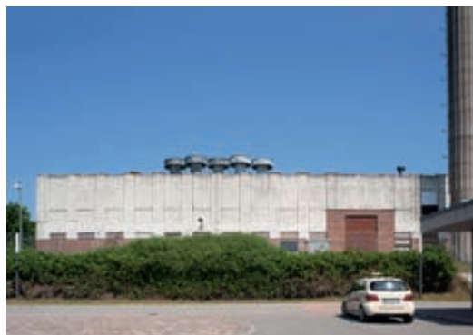
Letzter Bau des Instituts aus DDR-Zeiten ist der Isolierstall an der „Wache Süd“, fertiggestellt im Jahr 1990
