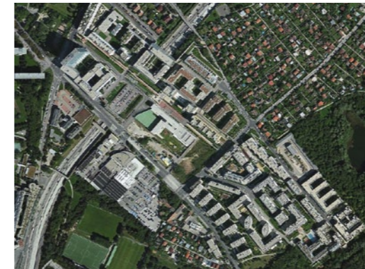
Für den Bau der Wohnsiedlung wurde die Autobahn A23 auf einer Länge von 200 Metern überdeckelt
