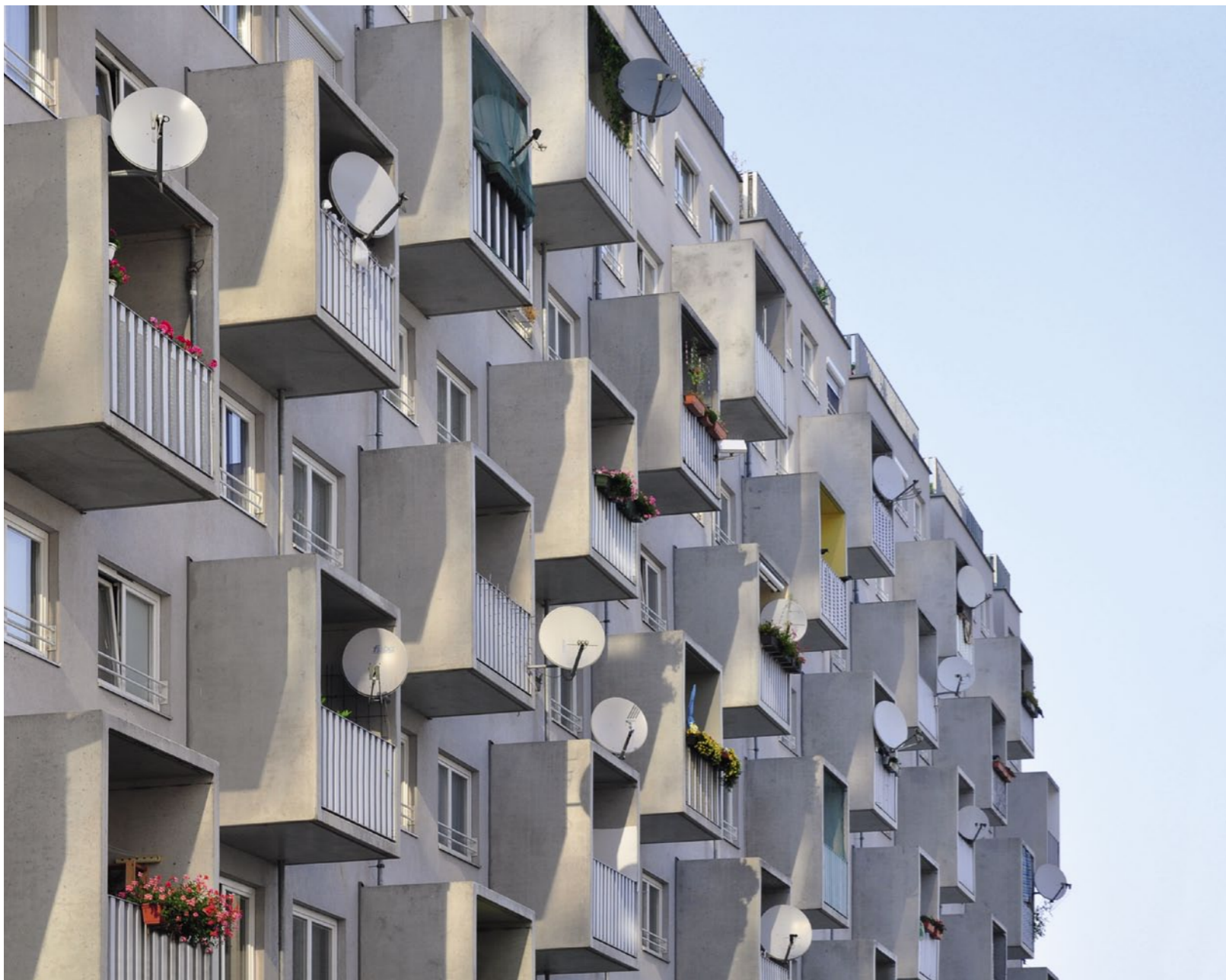
Die „Loggien“ an einem Wohngebäude des Architekten Adolf Krischanitz
