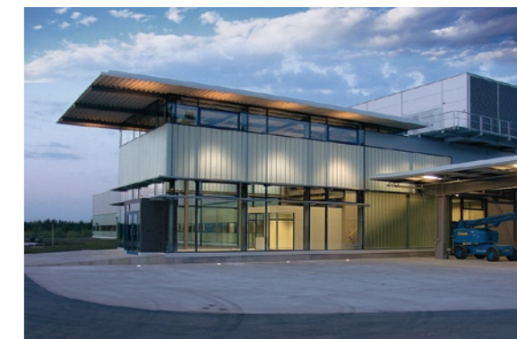
„Just in sequence“. Das neue Montagewerk von Modine auf einer Fläche von 108 m x 82 m produziert täglich rund 3000 Kühlsysteme mit einer Zwischenlagerung von maximal zwei Tagen. Durch zwei Technikzentralen auf dem Dach konnte in der Halle Platz gewonnen werden. Die Fassaden gliedern sich in horizontale Bänder aus Stahlblech-, Klarglas und Gussglasflächen. Unten: Der Vorbau im Westen mit den Eingangshalle.
