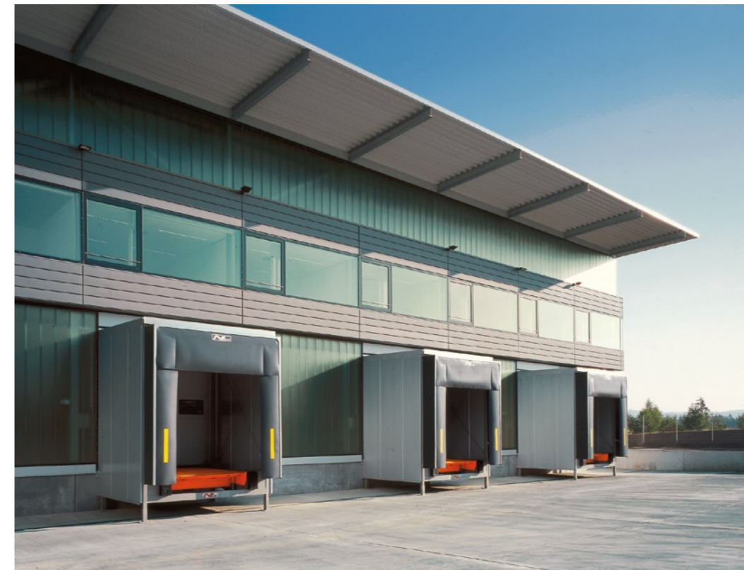
„Just in sequence“. Das neue Montagewerk von Modine auf einer Fläche von 108 m x 82 m produziert täglich rund 3000 Kühlsysteme mit einer Zwischenlagerung von maximal zwei Tagen. Durch zwei Technikzentralen auf dem Dach konnte in der Halle Platz gewonnen werden. Die Fassaden gliedern sich in horizontale Bänder aus Stahlblech-, Klarglas und Gussglasflächen. Unten: Der Vorbau im Westen mit den Eingangshalle.
