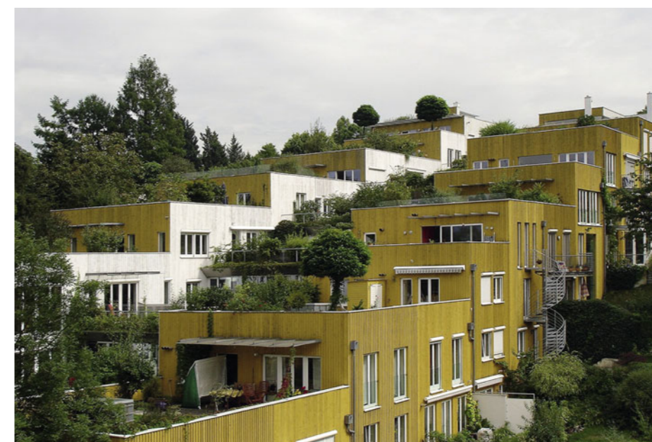
Les Palétuviers 16, 2001 | In Linz ist die aktuellste Palétuviers-Anlage entstanden. Der Gemeinschaftsraum ist eine terrassierte Achse.
