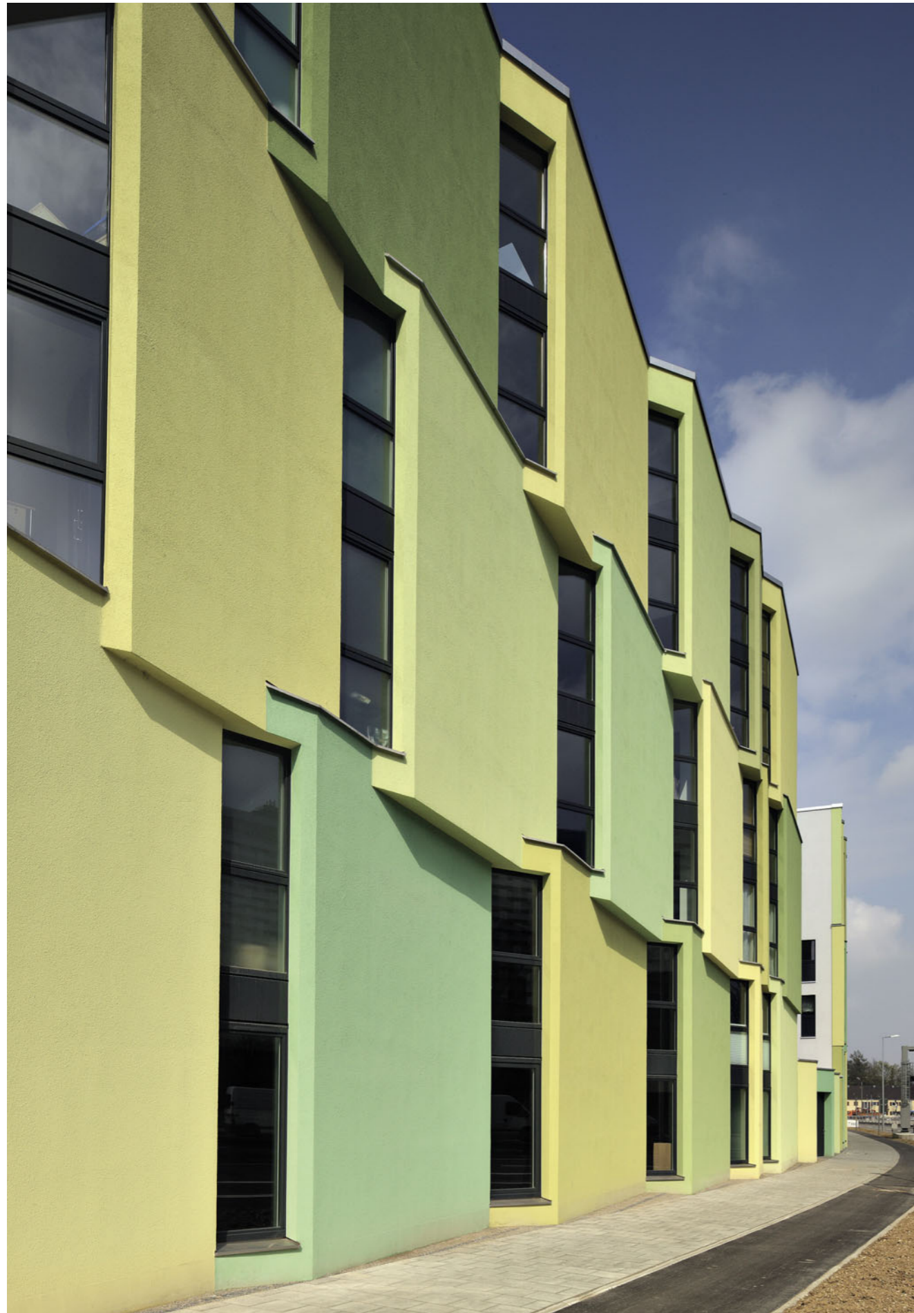
Die grün verputzten Flächen der Fassade fassen jeweils zwei Geschosse zusammen und öffnen sich nach Süden.
