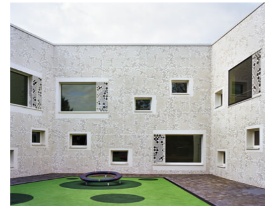
Im Flurbereich gibt es einen Wechsel zwischen kleinen und großen Öffnungen. Der große Fenstertyp wurde aus den Klassenzimmern übernommen. Das Muster für die Fassadengestaltung und die Blechverkleidung der großen Fenster stammt von einem Militär-Tarnnetz, das für die Garderobenvorhänge verwendet wurde. Auf die Gestaltung des Spielhofs hatten die Architekten keinen Einfluss.
