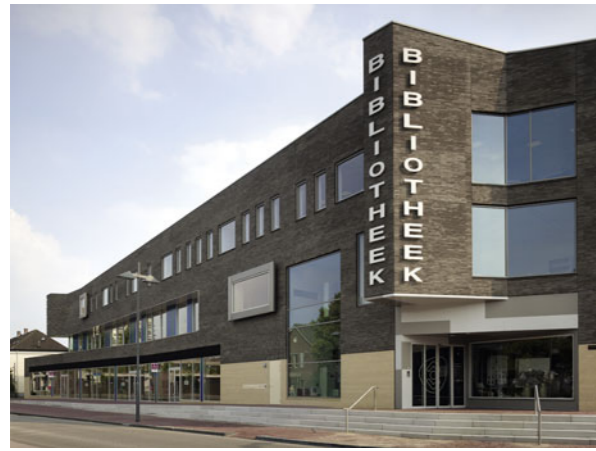
Straßenseite der Bibliothek mit den „Mendelsohn-Ohren“. Unten: Eingangsfoyer mit Treppenaufgang zur Bücherei.
