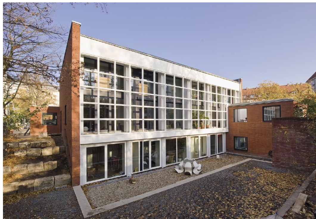
Die Turnhalle wurde parzelliert und mit dreigeschossigen Reihenhäusern gefüllt. Die filigrane Betonrasterfassade wirkt als „brise soleil“ für deren großflächige Verglasung nach Süden.
