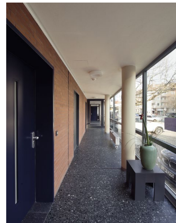
Im Klassentrakt wie im Flachbau der ehemaligen Bibliothek liegt hinter der erhaltenen Fassade ein Laubengang als Pufferraum
