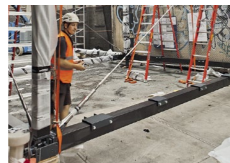
Stabenden werden mit Stahlstangen verspannt
