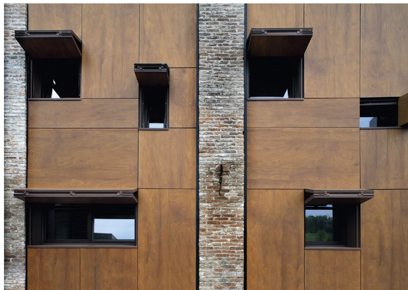
Die Felder zwischen den Ziegelpfeilern wurden mit furnierten Verbundwerkstoffplatten gestaltet, die bei den Fenstern als Klappläden dienen
