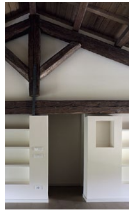
Auf der Westseite entstand unterm Dach eine Wohnung für den Bauherrn
