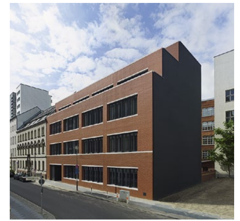
Die Kubatur war wegen der Nachbarbebauung vorgegeben. Im Hintergrund rechts der Altbau
