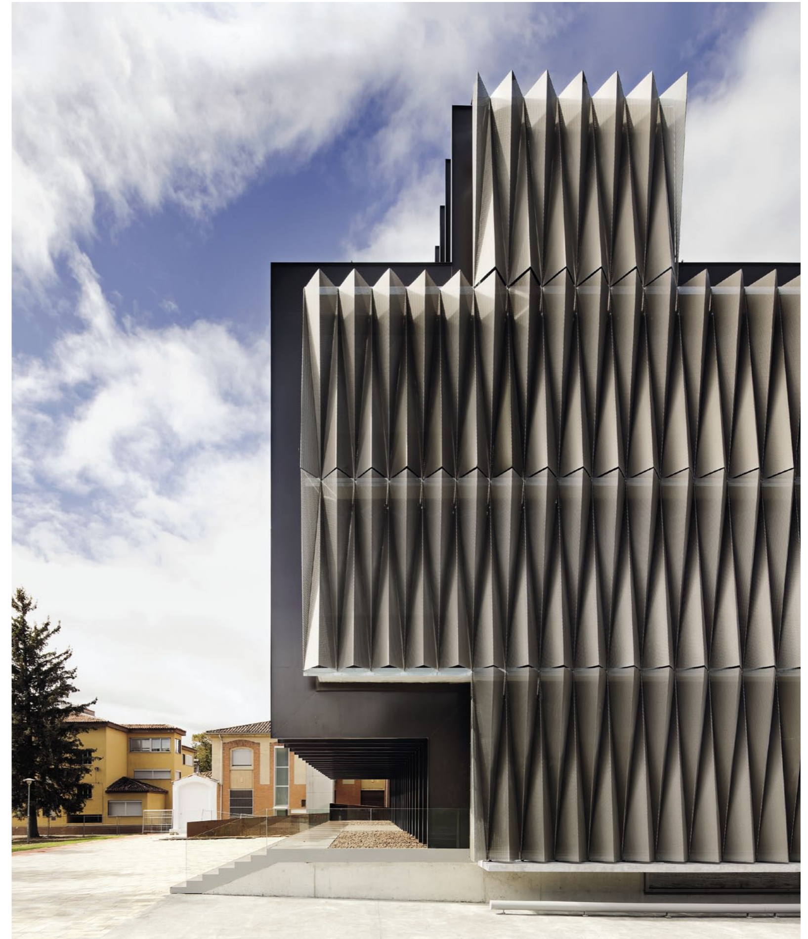
Eine Faltung der tragenden Stahlrippen bildet ein Vordach über dem Haupteingang
