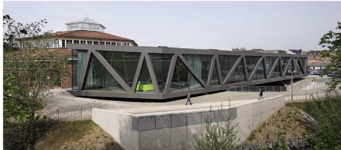
Der Anbau „schwebt“ über dem Terrain. Vorne das neue Lüftungsbauwerk, mit dem kühle Luft aus dem Bachbett der Ahna angesaugt wird
