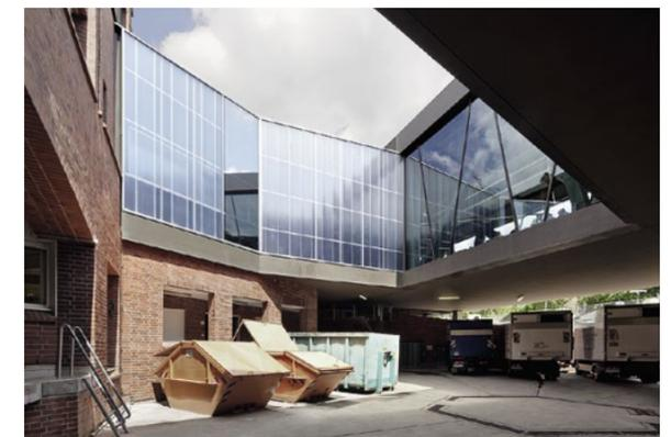
**Der Wirtschaftshof wird durch den neuen Saal überspannt. Oben: der Anschluss an den Altbau mit seiner Fassade aus Polycarbonat-Stegplatten**
