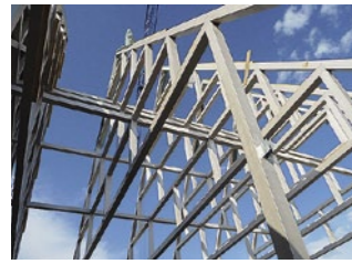
Das Dachtragwerk, noch ungedeckt während der Bauzeit
