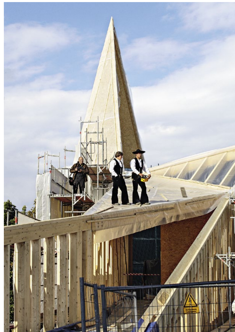
Die vorgefertigte Holzkonstruktion verschwand nach dem Richtfest unter der Verkleidung mit OSB-Platten.
