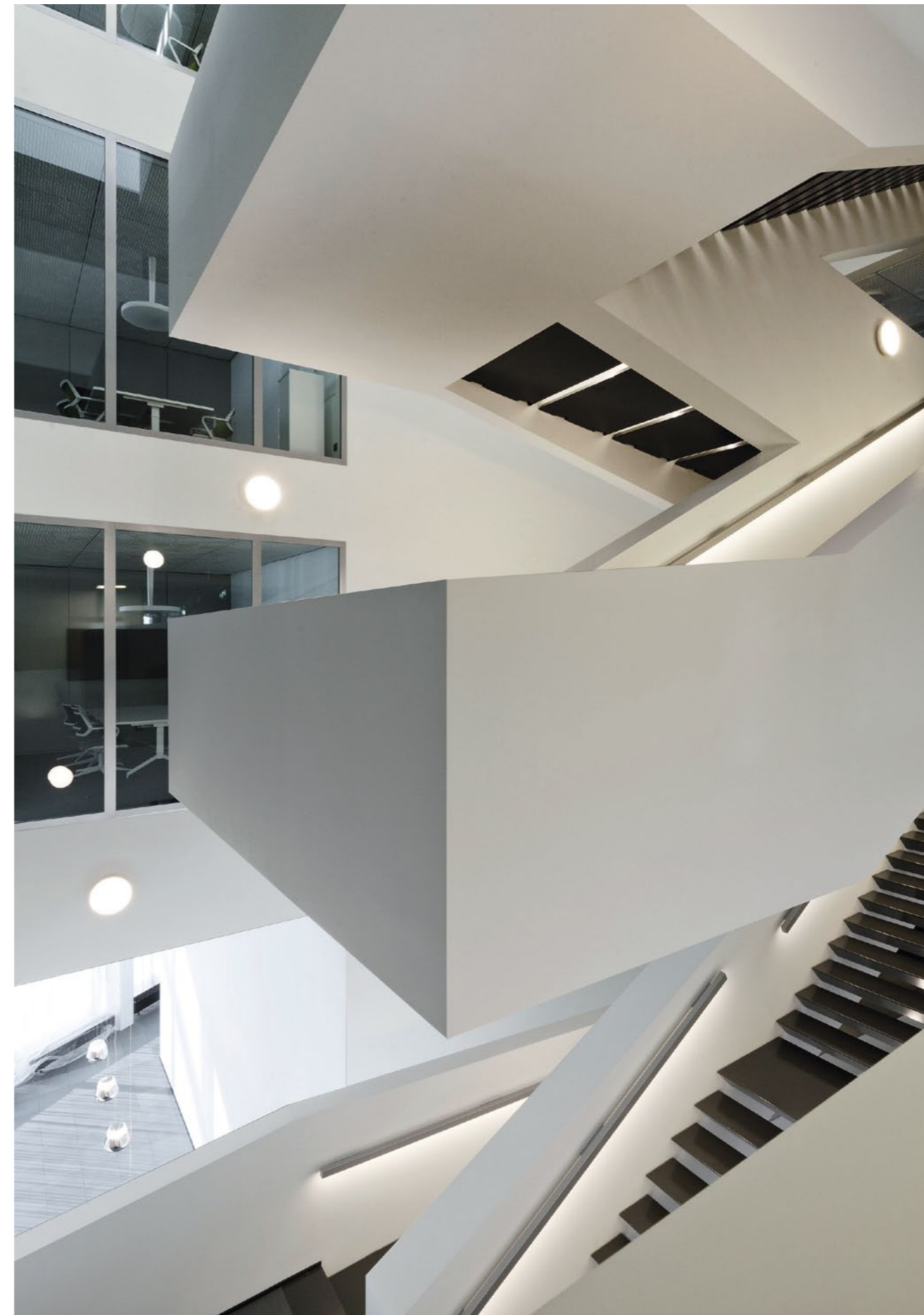
Die frei im Foyer hängende Treppe mit unterschiedlichen Steigungen der Läufe bildet eine Promenade durch das Sockelgebäude aus
