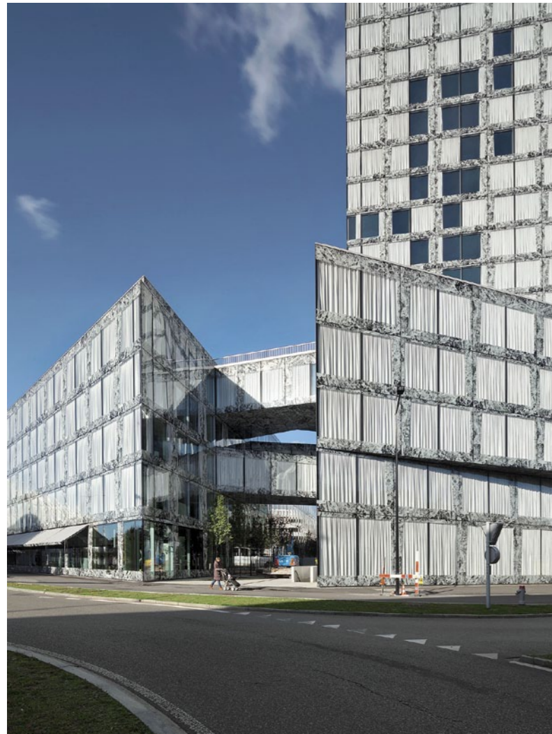
Die Verbindung von aluminiumbedampften Vorhängen und Glaselementen mit Siebdruck à la Barcelona-Pavillon will den konträren Vorgaben des Städtebaus (Steinernes Wallisellen) und des Hauptmieters (Glasarchitektur) gerecht werden.
