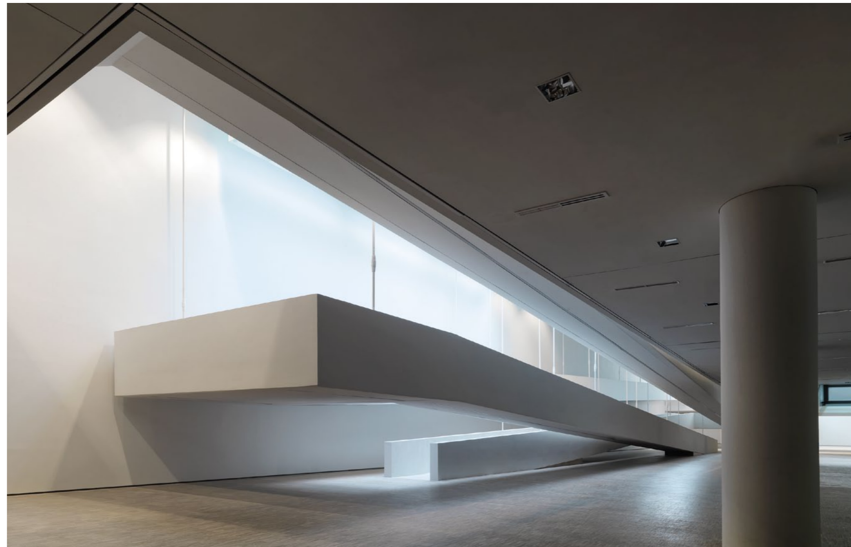
Der vertikale Lastabtrag konnte im Bereich der Dauerausstellung auf eine Stützenreihe im Raum beschränkt werden, um die Fläche möglichst frei „bespielbar“ zu machen
