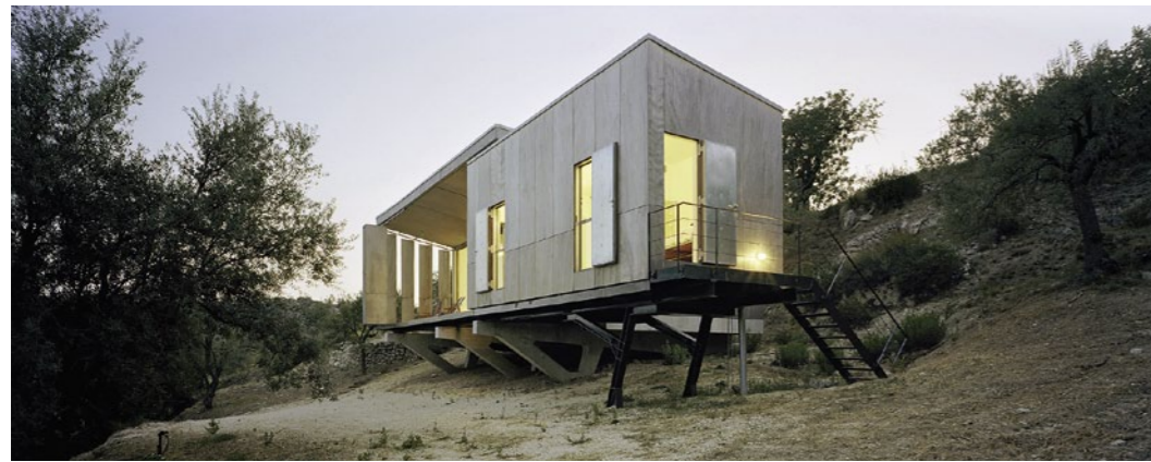
Oben: Ferienhaus in Noto, 2009. Reisen die Bewohner ab, schließen sie die Holzläden und schieben den herausgefahrenen Kubus zurück unters Vordach. Unten: Blick in die Ausstellung im aut Fotos: Armin Linke (oben); Günter Richard Wett (unten)
