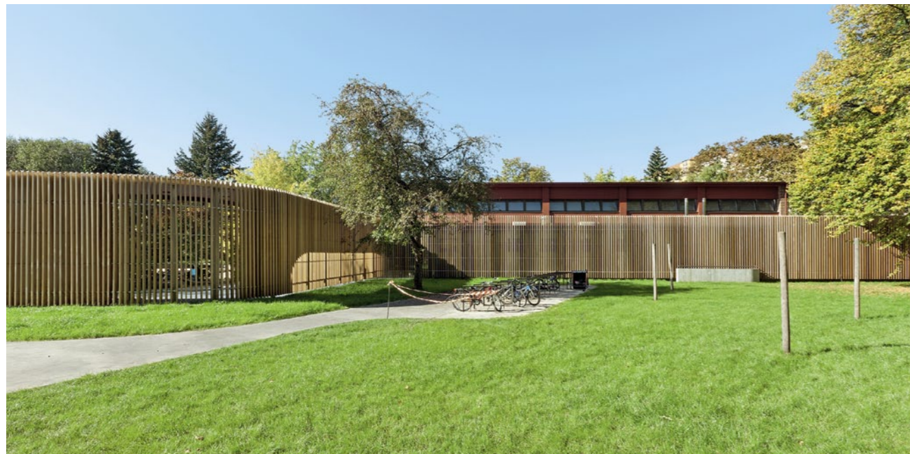
Der geschwungene Gang schirmt den Schulhof ab, die Holzlamellen leiten zu Halle über und dienen dort auch als Graffiti-schutz.
