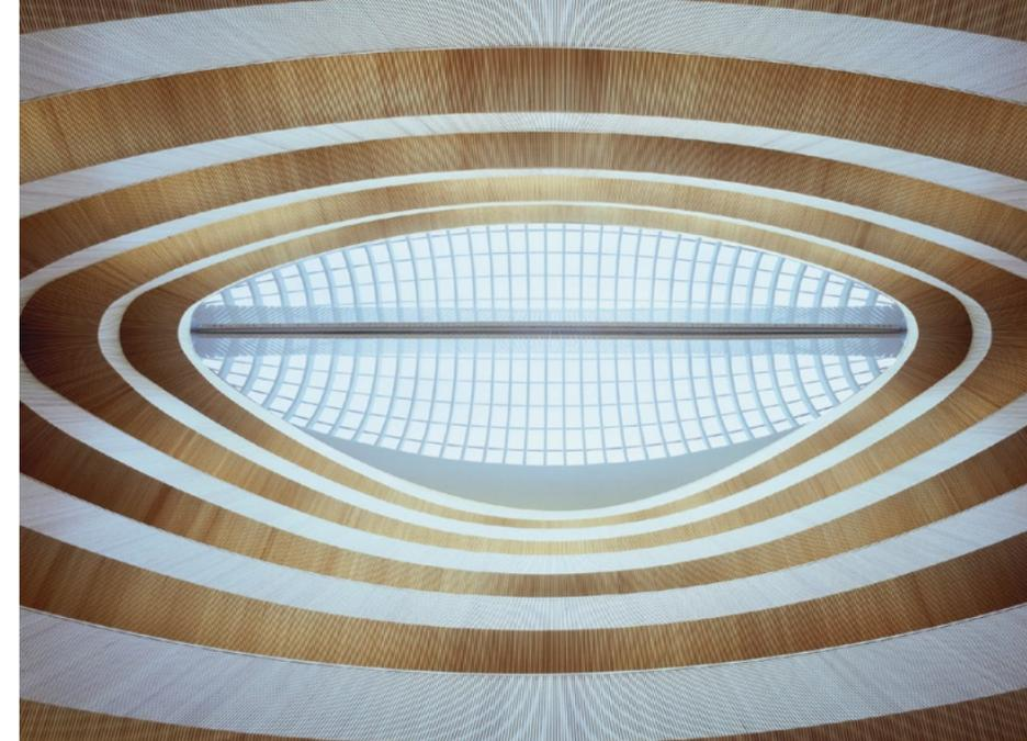
Der 34 Meter langer Hohlkastenträger der Dachkonstruktion überspannt das Atrium in Längsrichtung. Über zwei Querjoche wird die Last auf zwei neue Stahlbetonkerne an den Längsseiten des Hofes übertragen.
