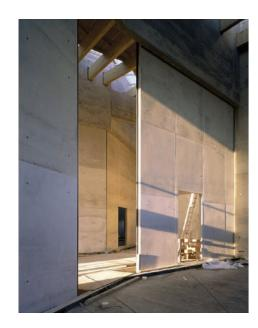
Die über acht Meter hohen Wände aus Ortbeton verlangten eine besonders präzise Ausführung. Sie sind auf Stahlrädern gelagert und lassen sich mittels Elektromotoren verschieben. In die mittige Öffnung der Wände werden noch kleinere Holztüren eingesetzt.
