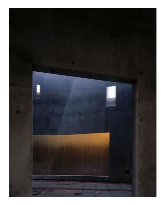
Die Längsseiten des Gebäudes oben im Bild der katholische Kirchenraum - sind nach außen geneigt und mehrfach asymmetrisch gefaltet. Das rechte Foto zeigt den großen Wandausschnitt hinter dem künftigen Altar, der durch indirek ten Lichteinfall bei entsprechendem Sonnenstand eine rötliche Färbung annimmt.
