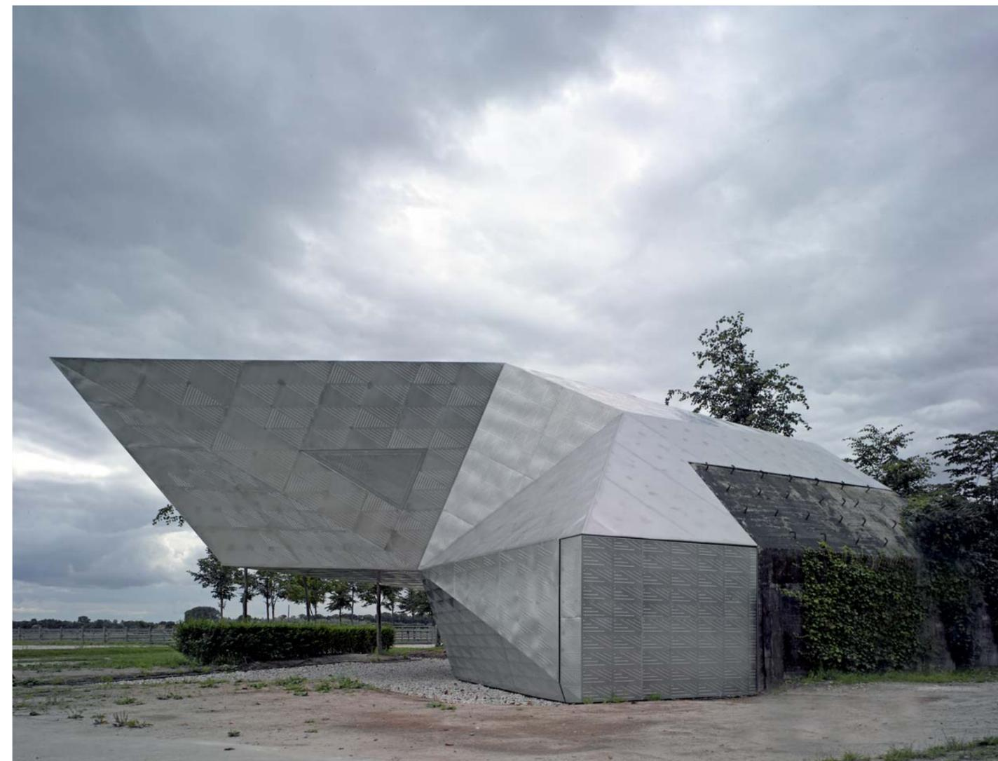
Der denkmalgeschützte Bunker (vor dem Umbau, links) bildet das Gegengewicht für den auskragenden Aufbau. Die Addition erhielt eine Edelstahlverkleidung, der Eingang
