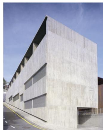
Das in die Hanglage eingefügte Ensemble öffnet sich nach Osten mit einem vorgelagerten Platz auf dem halb eingegrabenen Theatersaal. Die Südfassade (oben) aus Sichtbeton ist großflächig geschlossen, die Nordfassade verglast.
