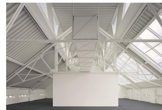
Transformation des einstigen Malersaals in einen Ausstellungsraum. Im Traufbereich wurde das Dach nach oben aufgestülpt. Das große Foto zeigt die Treppe zur Terrasse.
