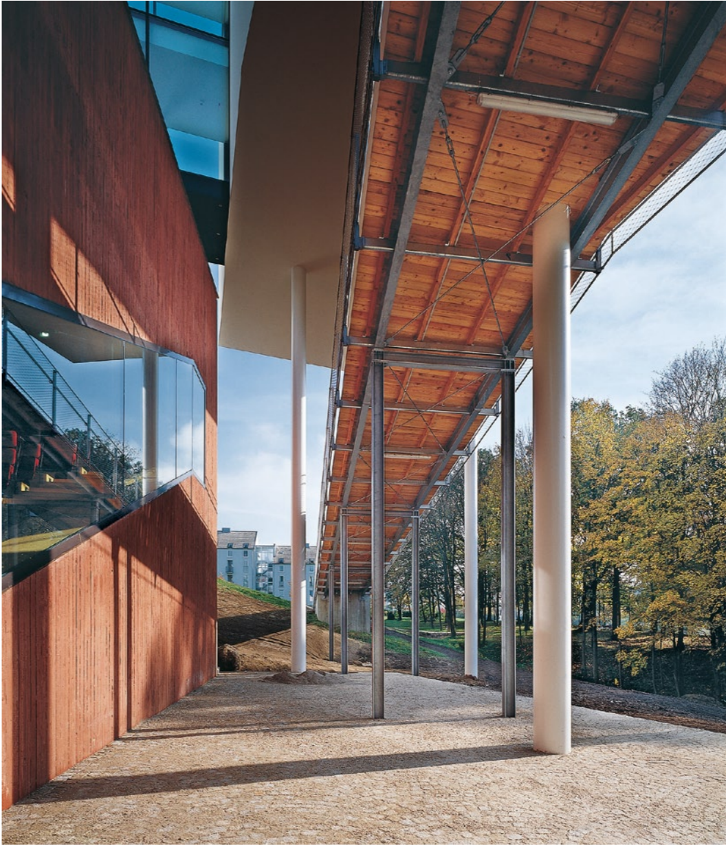
Die Hörsäle sind als eigenständige Volumen unter den aufgeständerten „Vierkanter“ geschoben. Links: die Untersicht der Fußgängerrampe, die in das Ortszentrum führt. Oben: der Blick in die Bibliothek Längsschnitt im Maßstab 1:1000 Fotos: Gerald Zugmann, Wien
