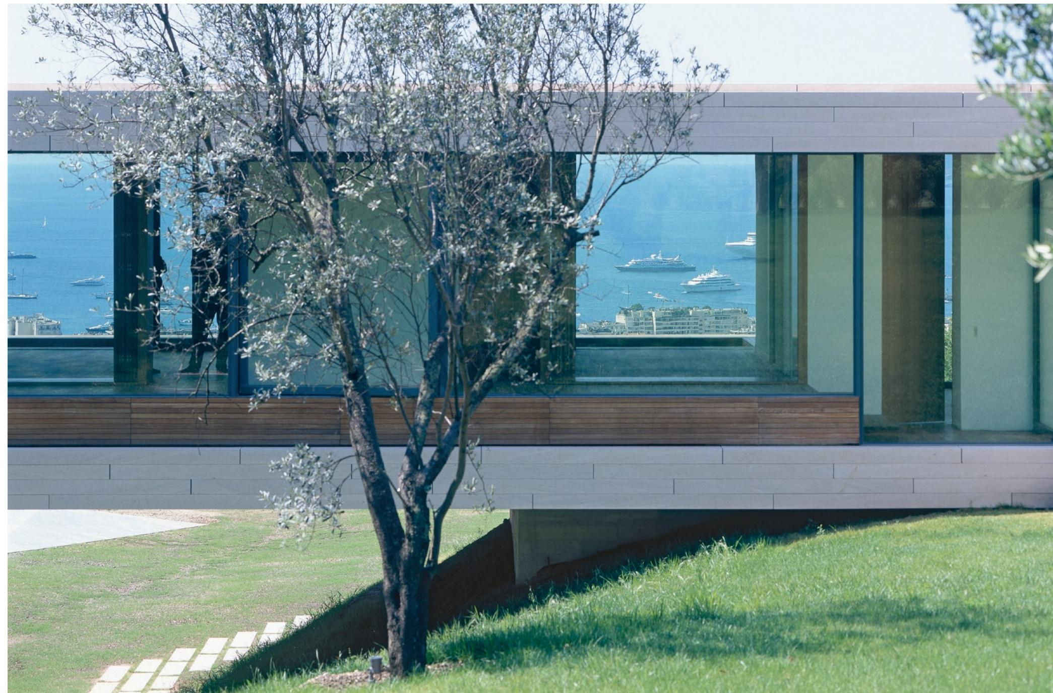
Ist Intimität gewünscht, können die gläsernen Zimmer in der Brücke durch Holz-Klappwände zum Meer und zum Hang hin abgeschottet werden. Die gut sichtbaren Fugen der Stone Panels sollen ganz bewußt als leichte Verkleidung der Brücke gelesen werden.
