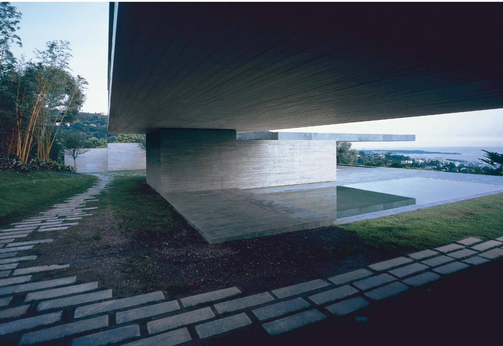
Der zweite Gebäudeteil ist als Brücke ausgebildet. Mit der breiten Unterquerung wird der rückwärtige Hang mit dem Bambuswald Teil der Raumabfolge. Die Zufahrt der Villa endet hinter der Mauerscheibe im Hintergrund links.
