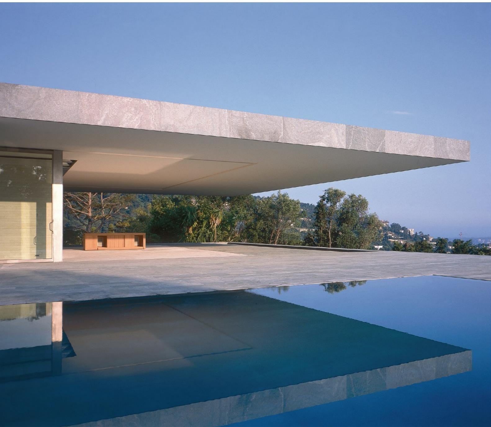
Die insgesamt 20 Tonnen schwere Stahlglasfassade des Salons kann in Segmenten oder als Ganzes in den Boden gefahren werden. Das Dach krägt dann 12,5 Meter aus.
