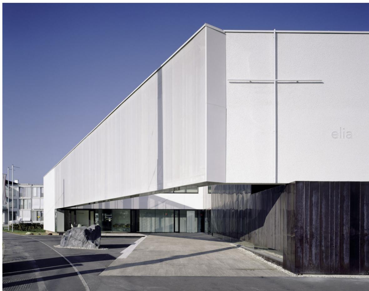
„Solarportal“ nennen die Architekten den liegenden Balken, der den Vorplatz von der Solaranlage abschirmt. Integrierte Solarpaneele sammeln Strom für das nächtliche Leuchten der transluzenten Stahlglaskonstruktion in den liturgischen Farben der jeweiligen Jahreszeit (siehe Seite 31).
