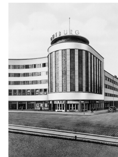
Die Gartenstadt Atlantic von Rudolf Fränkel entstand in den zwanziger Jahren. Blick vom neuen Gesundbrunnen-Center in die Behmstraße. Oben: Blick von Norden in die Zingster Straße und historisches Foto der Lichtburg, die 1970 abgerissen wurde. Die Lagepläne zeigen das Areal mit der Gartenstadt 1928 und 2006.
