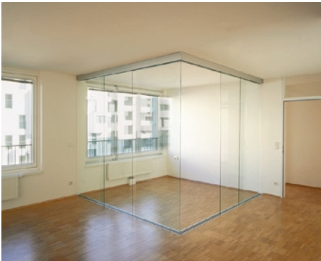
Das „Schaltelement“: Als Loggia definiert, kann dieser Bereich mittels eines dreiteiligen Faltschiebefensters in der Fassade als Freiraum oder Wintergarten genutzt werden. Die Glaschiebetüren schirmen ihn winddicht zum Wohnraum ab. Die Loggia kann aber auch vollkommen dem Wohnraum zugeordnet werden, z.B. in der kalten Jahreszeit. Rechts: Die 2-Zimmerwohnung wirkt dank dieses transparenten Elements wesentlich großzügiger, als sie ist.
