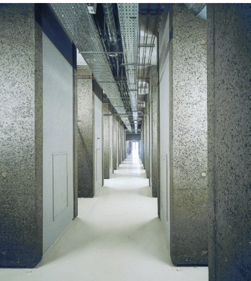
Blick in den Mittelgang des Laborbereichs: Die aufwendigen vertikalen Leitungsbündel sind zwischen den Stützen zusammengefasst. Rechte Seite: Die Laborräume sind in Zonen für Experimente und Bereiche für Schreibtischarbeit unterteilt.
