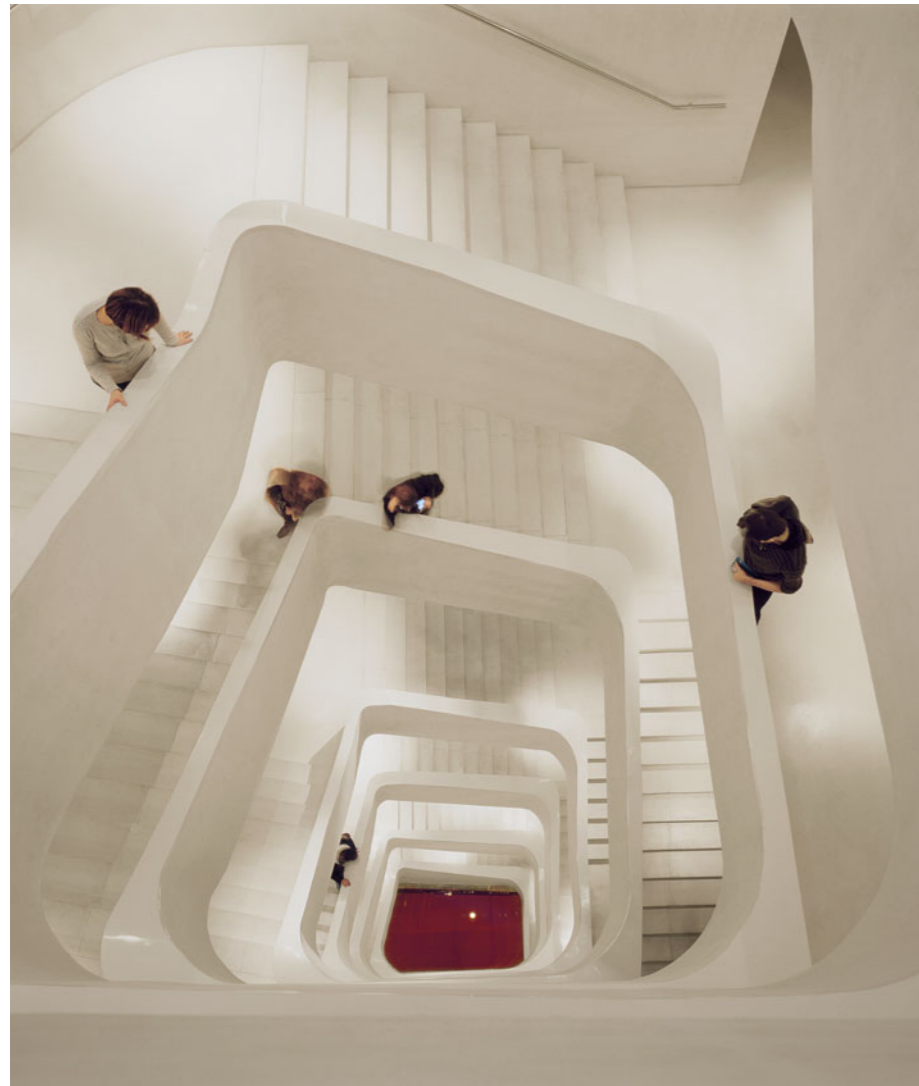
Das Haupttreppenhaus erweitert sich trichterförmig nach oben. Mit seinen abgerundeten Ecken entwickelt der Raum nach Plaza und Lobby ein neues gestalterisches Motiv.
