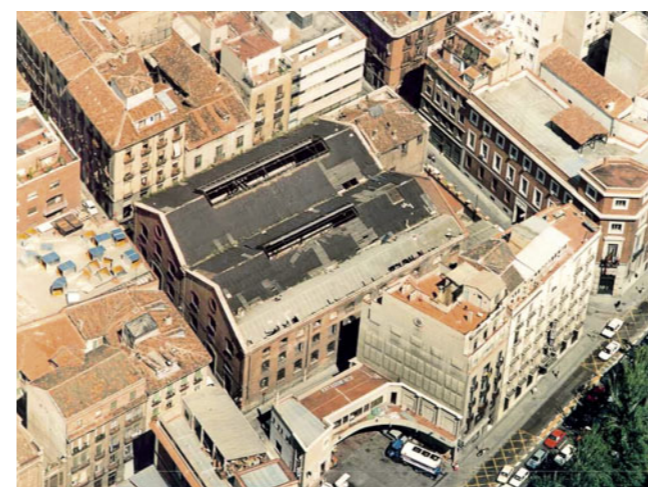
Vor dem Umbau war das leer stehende Kraftwerk in eine dichte Blockstruktur eingezwängt. Nach dem Abbruch der Tankstelle und eines Anbaus an der Nordwestecke öffnet sich das CaixaForum mit drei Plätzen zur Stadt. Unten die Nordansicht.
