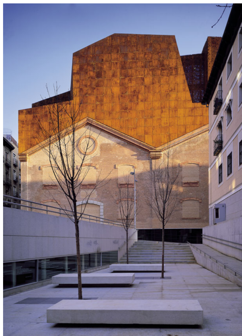
Blick von Süden. Die historischen Fenster wurden vermauert. In den Ausstellungssälen in den Obergeschossen bieten nur wenige neu ins Ziegelmauerwerk geschnittene Fenster Ausblick.
