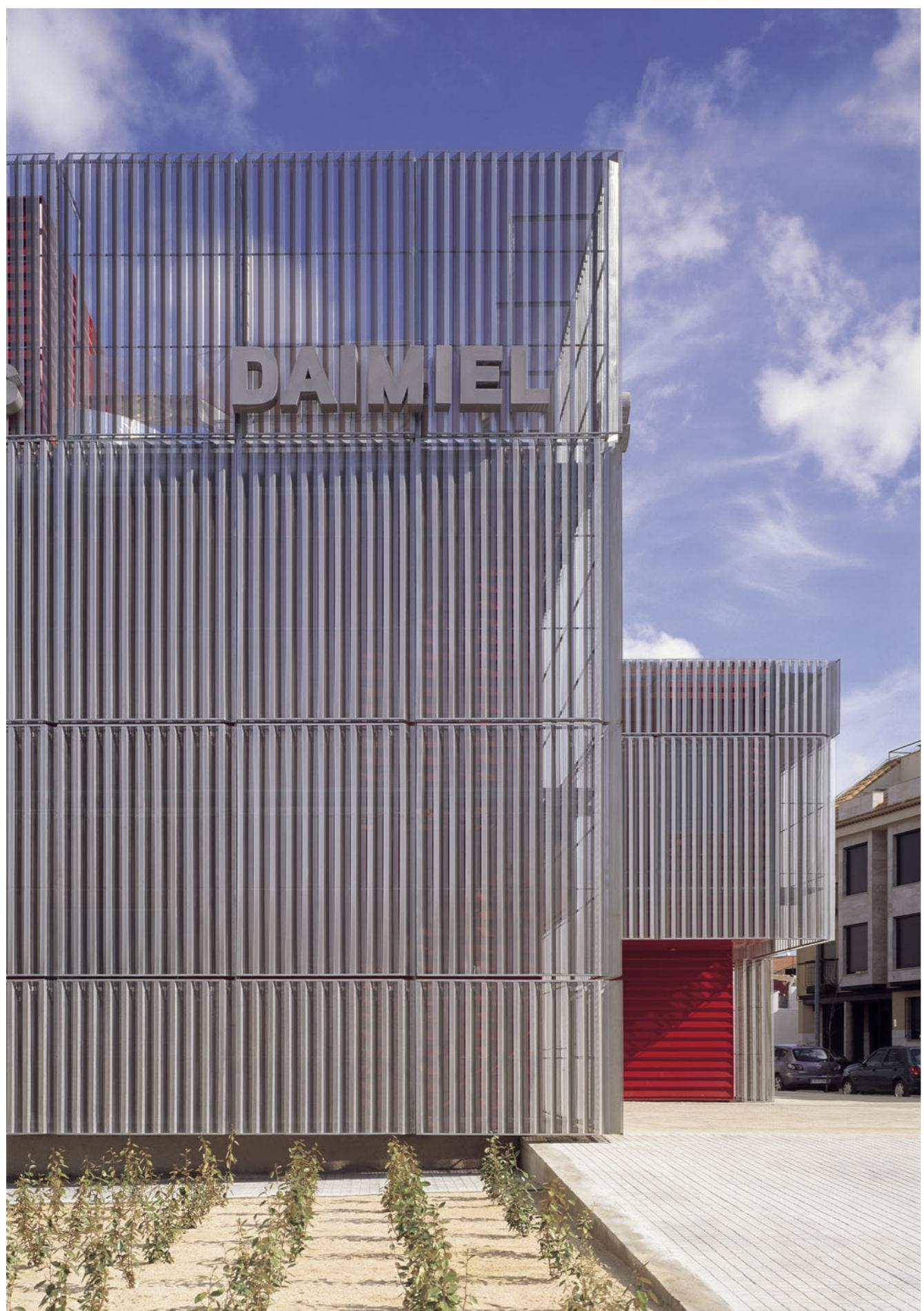
**Die Lamellelemente sind teilweise oberhalb der Fassade fortgeführt worden, damit sie die Technikaufbauten verkleiden. An den Eingängen tritt die eigentliche feuerrote Fassade in den Vordergrund. Durch die Perforierung der Lamellen kann man die äußere Umgebung gut wahrnehmen.**
