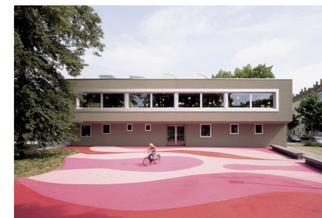
Beim Umbau wurde der Mittelflur zugunsten einer innenliegenden Nebenraumzone aufgegeben. Deren zum Flur zeigenden Wände wurden mit Schultafelfarbe gestrichen. Die Gruppenräume können über große Türen verbunden werden.
