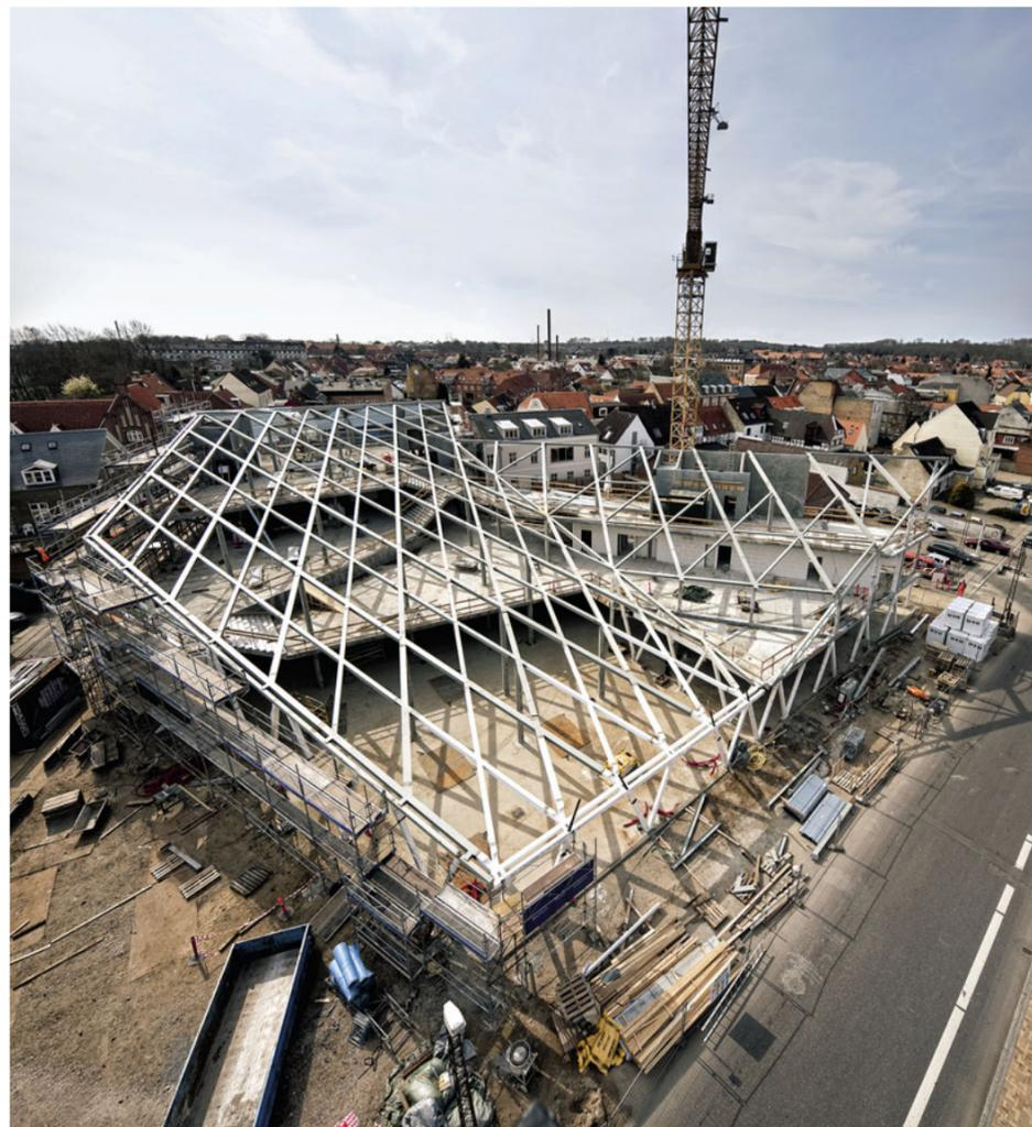
Die 83 vorgefertigten Elemente wurden innerhalb von drei Tagen montiert.
