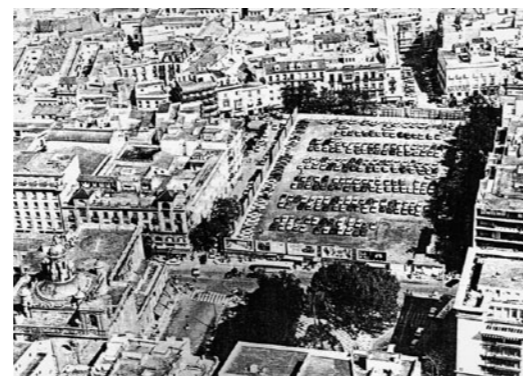
Der Südfassade der Hallen in den 1960er Jahren (links) und die den Platz schneidende Calle Imagen (Mitte). Nach dem Abriss der Markthallen 1973 diente die nördliche Teilfläche als Autoparkplatz.
