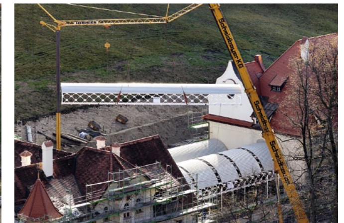
Montage eines seitlichen Segments zwischen dem Jägerhof und dem ehemaligen Hotel.
