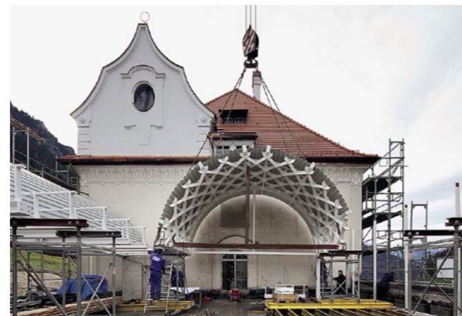
Montage eines der mittleren Segmente auf dem Erdschoss des Zwischentrakts.
