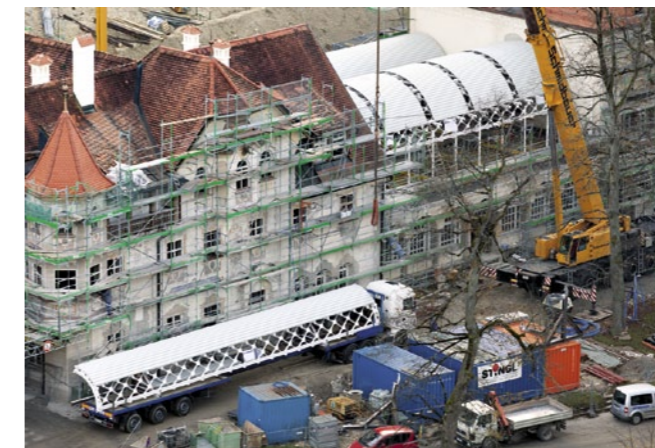
Die beiden seitlichen Tonnensegmente wurden in einem Stück angeliefert.
