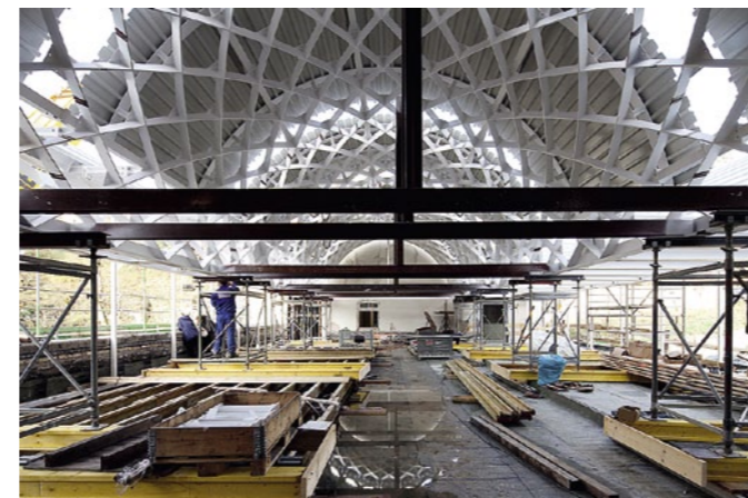
Untersicht des Gewölbes, unter dem sich der „Saal der Könige“ befindet.
