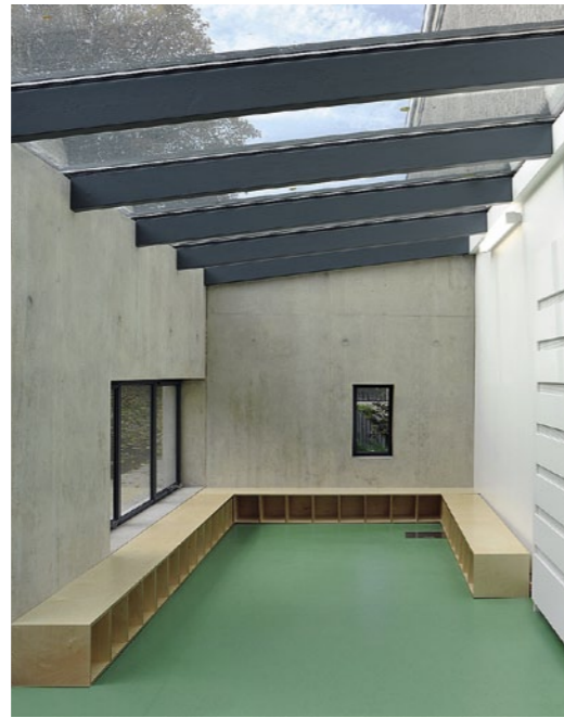
Auf der Südseite verraten zwei eingeschossige Anbauten die Erneuerung des Schulgebäudes. Sie setzen exakt unterhalb der Betonverkleidung des Obergeschosses an.
