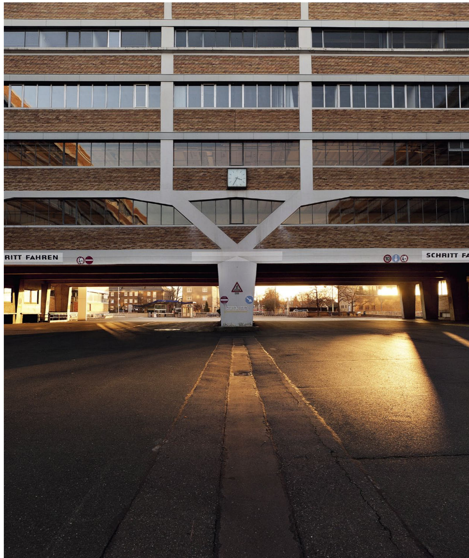
Stahlbetonskelett, Hartbrandstein mit ausgekratzten Fugen: Innenhof des Quelle-Versandhauses | Foto: Gao Liang
