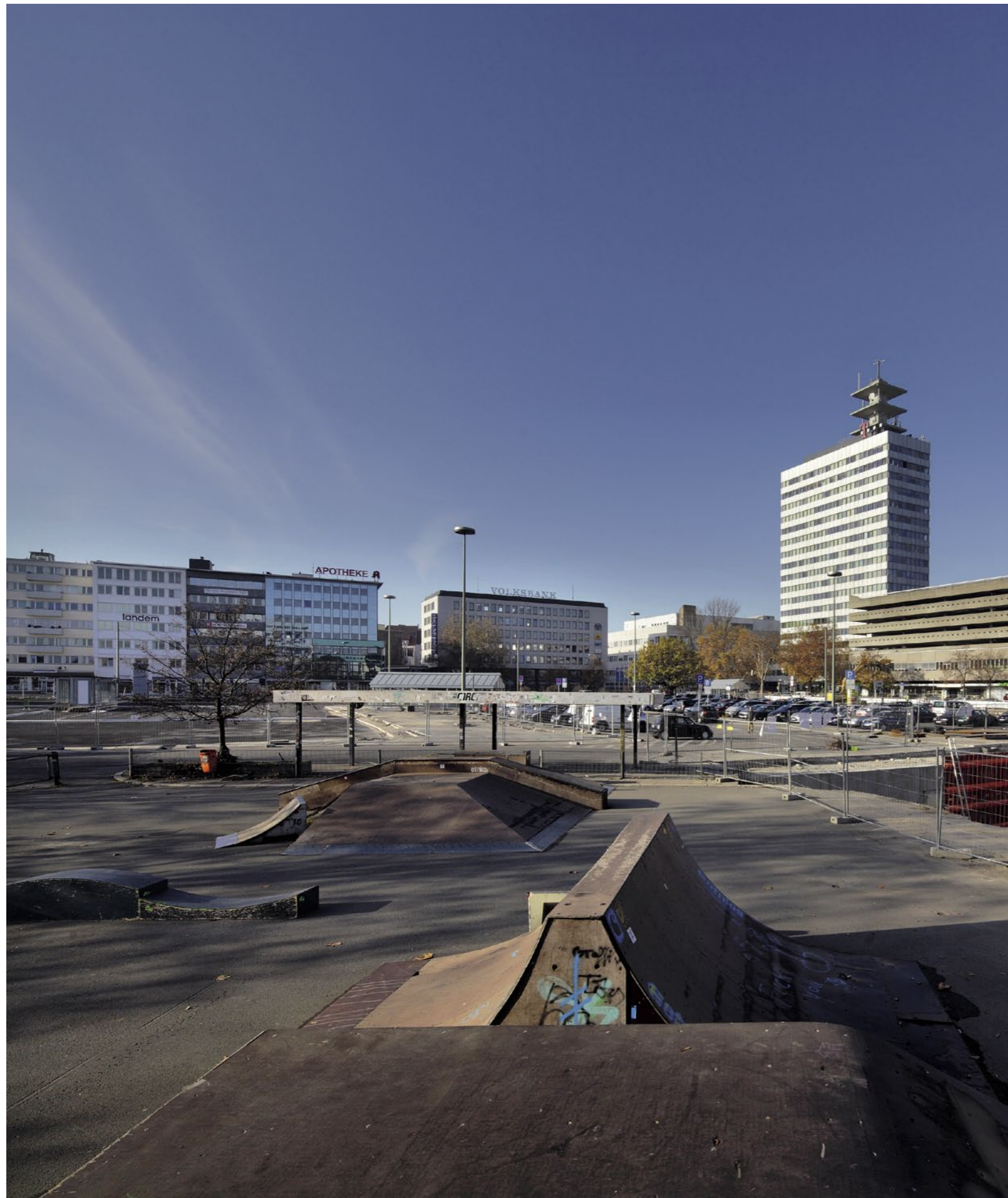
2011 entschieden – 2012 fertiggestellt: Die Baustelle am Bielefelder Kesselbrink lässt dieses Tempo auf den ersten Blick nicht vermuten.
