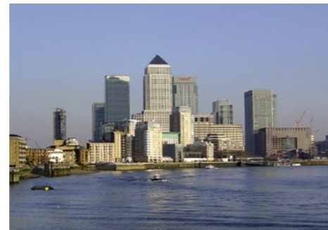
Baubeginn Canary Wharf ► BW 23.92
