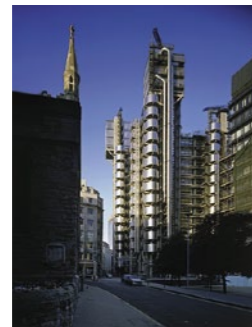
Fertigstellung des Lloyd's Buildings von Richard Rogers ► BW 13.86
