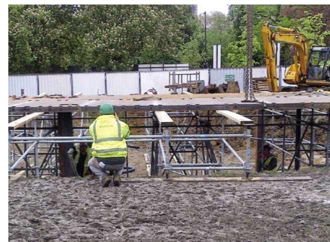
Auflegen der zweischaligen Dachsegmente
