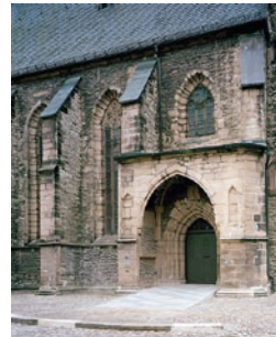
Die Kreise auf der neuen, ornamentierten Bodenplatte im Inneren der gotischen Kirche laufen erst auf dem Vorplatz aus.
